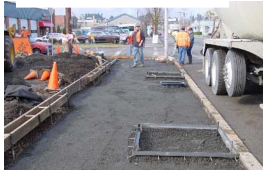
Project site, ready to pour concrete.
