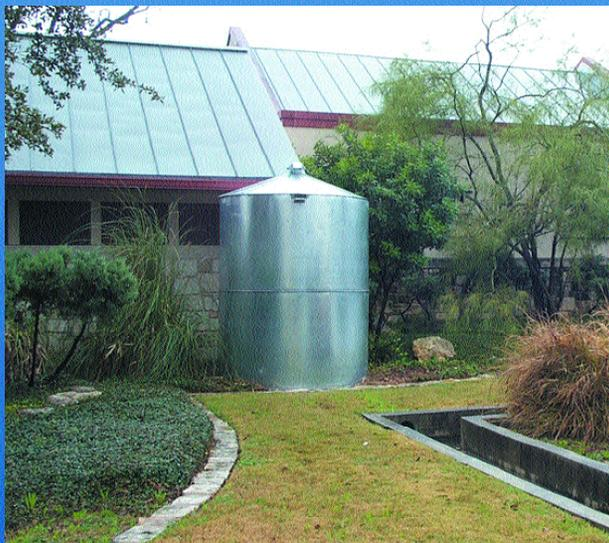
Tanques de almacenamiento de agua pluvial como esta cisterna grande de acero galvanizado, deben de colocarse lo más cerca posible a la fuente de agua y al paisaje donde será utilizada.
